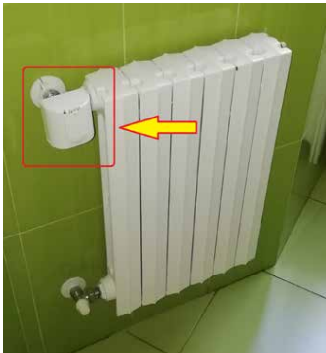
FIGURA 1 – Valvole termostatica SMART installata su un corpo scaldante di una toilette dell'istituto Gonzaga di Milano. Invasività minimale
